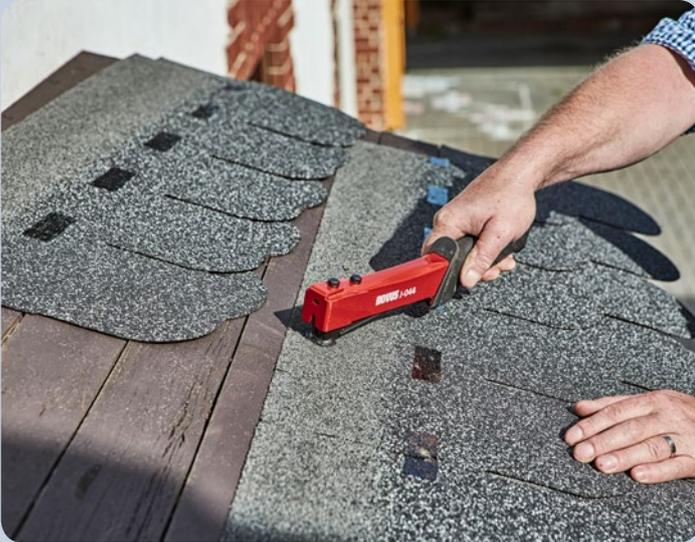
Schnelles Befestigen von Bitumenschindeln.
