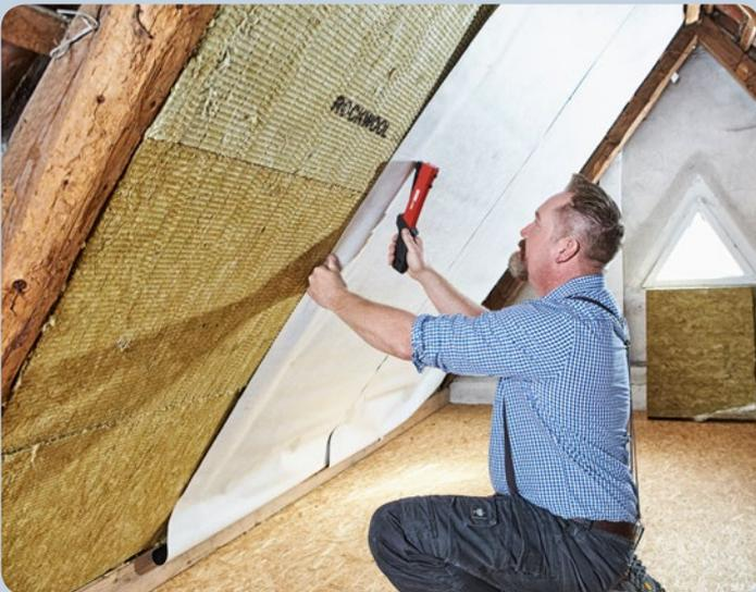
Folie beim Dachbodenausbau einfach befestigen.
